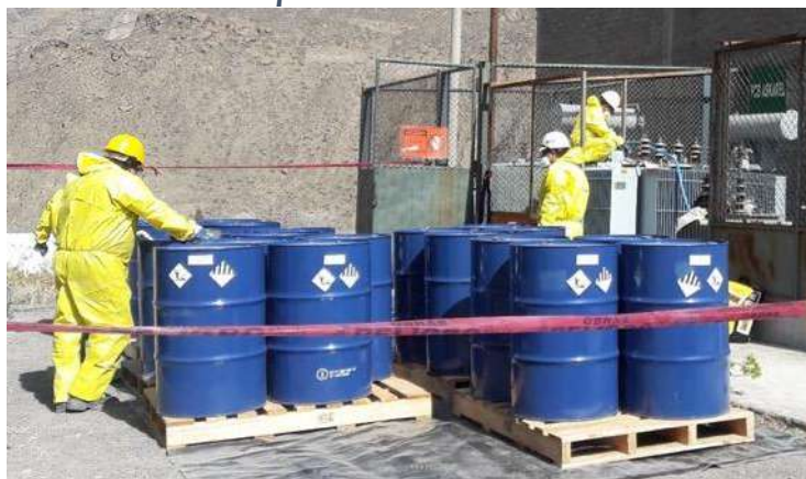
Gráfico N° 16: Cilindros NNUU conteniendo aceite con PCB listo para ser transportado hacia el Puerto
