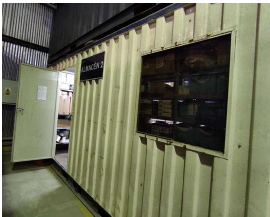
Km 65 de la carretera Cañete – Yauyos. San Juanito
