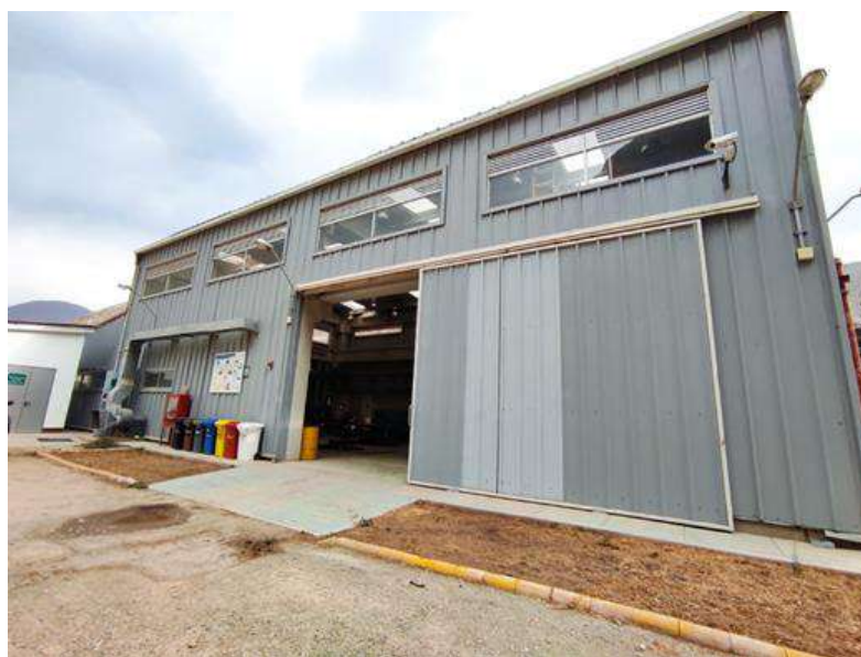
Km 65 de la carretera Cañete – Yauyos. San Juanito
